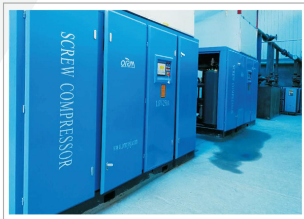
某知名酒业玻璃瓶厂低压机系统及安装工程
