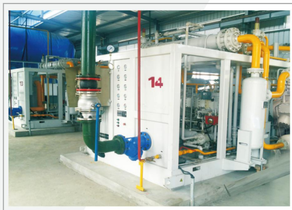
某化工集团氢气充瓶压缩机项目及安装工程
