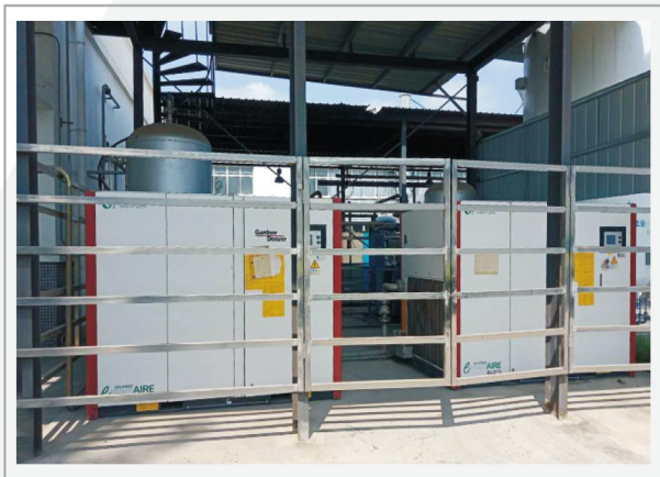
某航空航天集团空压机系统及安装工程
