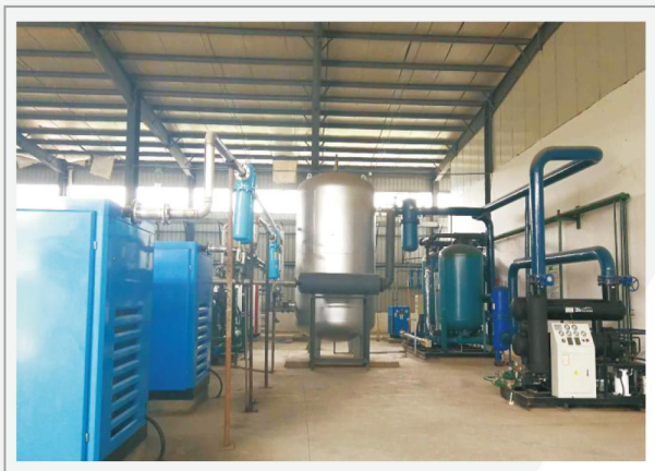
某生物制药公司低压机系统及节能改造安装工程
