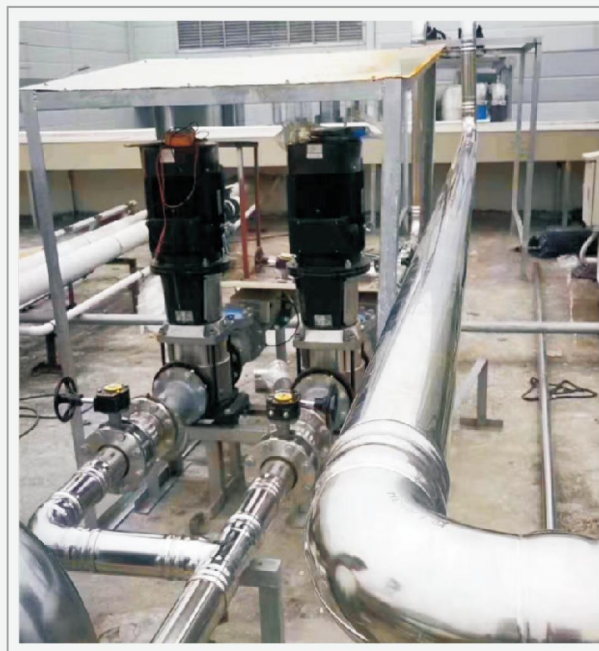
某合金公司环压式薄壁不锈钢管路供水项目
